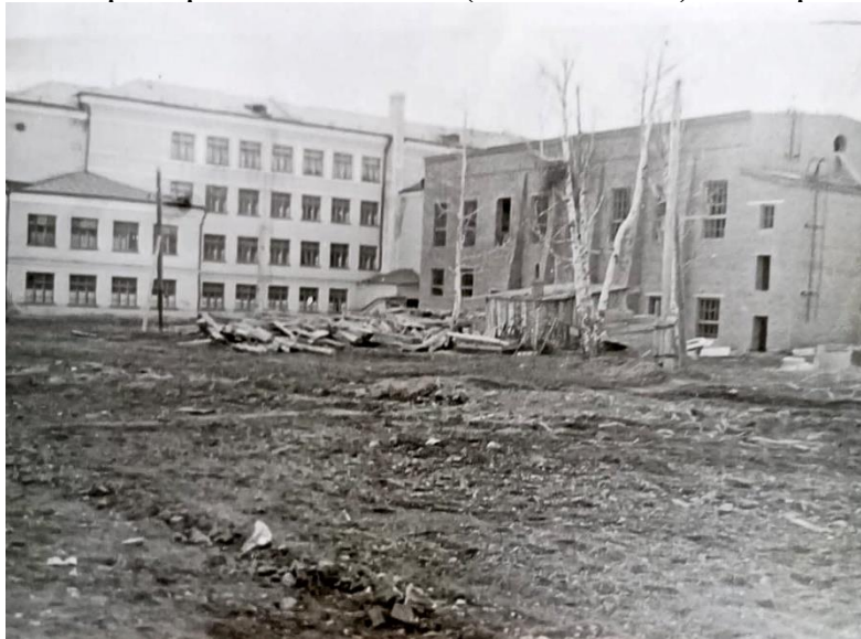
Фото 2. Строительство актового и спортивного залов в Кировском районе,
