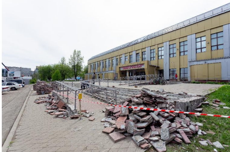
Фото 6. Главный корпус на улице Ворошилова, 22а во время реконструкции крыльца.
